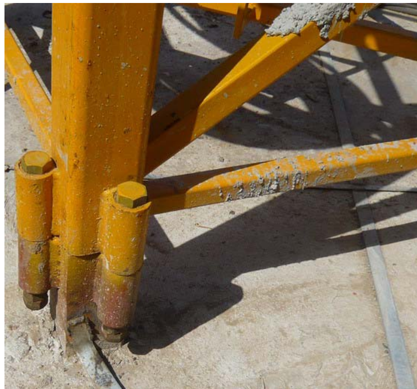
基础对角接地
