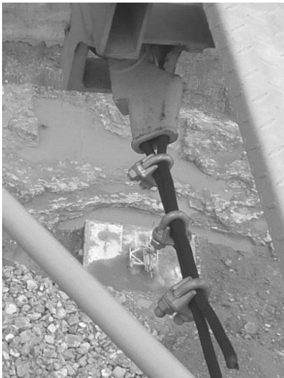
图4.1-2楔块固定穿绳方法正确
