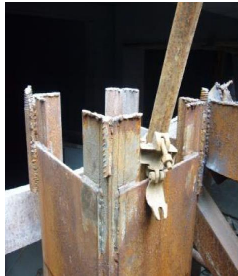
钢平台与格构柱的焊接未设加筋板，且全部焊缝几乎都为虚焊的事故案例
