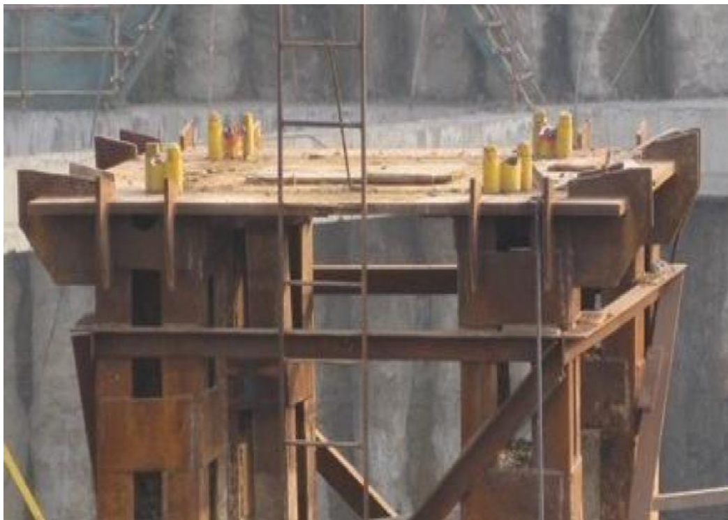
钢平台直接与出厂年限较长的标准节相连，塔机受冲击后标准节连接处全部断裂。
