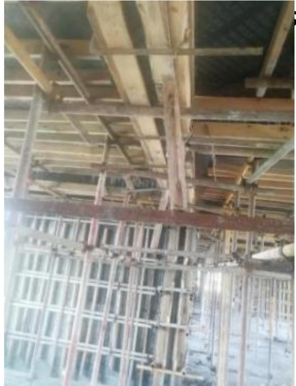
《建筑施工扣件式钢管脚手架安全技术标准》T/CECS 699-2020：构造二节点满堂脚手架：节点处受力水平杆与立杆扣接，其垂直下方水平杆与立杆扣接，且扣件顶紧上方扣件的满堂脚手架，宜用于安全等级Ⅱ级的支撑系统，也可用于作业脚手架。用于作业脚手架时，应按作业脚手架规定的荷载取值计算。
