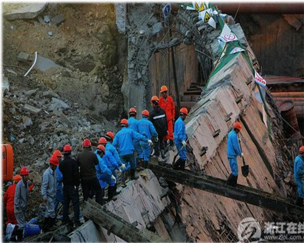
首先西侧中部地下连续墙横向断裂并倒塌，倒塌长度约75m，墙体横向断裂处最大位移约7.5m，东侧地下连续墙也产生严重位移，最大位移约3.5m。由于大量淤泥涌入坑内，风情大道随后出现塌陷，最大深度约6.5m。地面塌陷导致地下污水等管道破裂、河水倒灌造成基坑和地面塌陷处进水，基坑内最大水深约9m。
