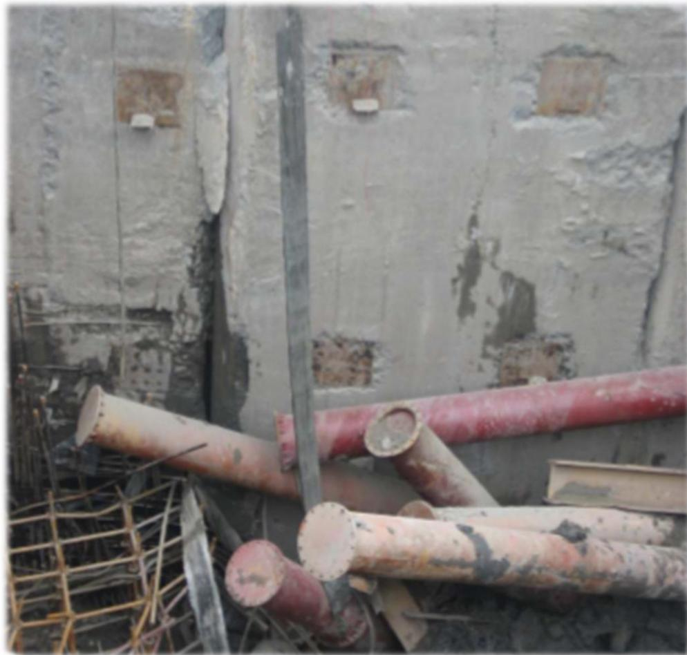
⑥部分钢支撑的安装位置与设计要求差异较大
