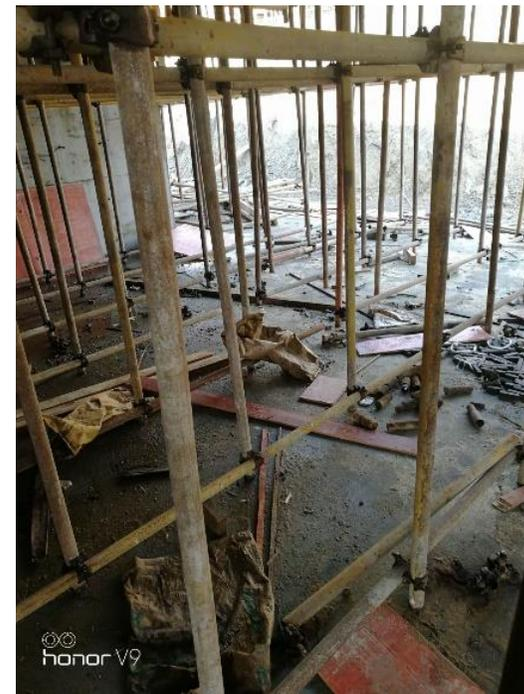
模板支架宜采用 $\phi 48.3 \times 3.6\text{mm}$ 的钢管，壁厚不得小于 $3.24\text{mm}$ ；也可采用 $\phi 48 \times 3.5\text{mm}$ 的钢管，壁厚不得小于 $3.0\text{mm}$ 。同一模板支架应采用同一规格的钢管。
