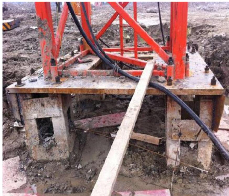
连接处的结构刚度严重突变
